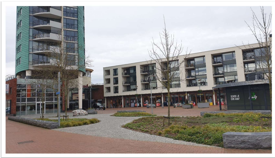
Figuur 4.22 Israëlplein en ingang 't Rond: aantrekkelijke pleininrichting en bekende ketens in commerciële plint
